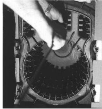
Afb. 15 Remplaten verwijderen en de ketel reinigen
